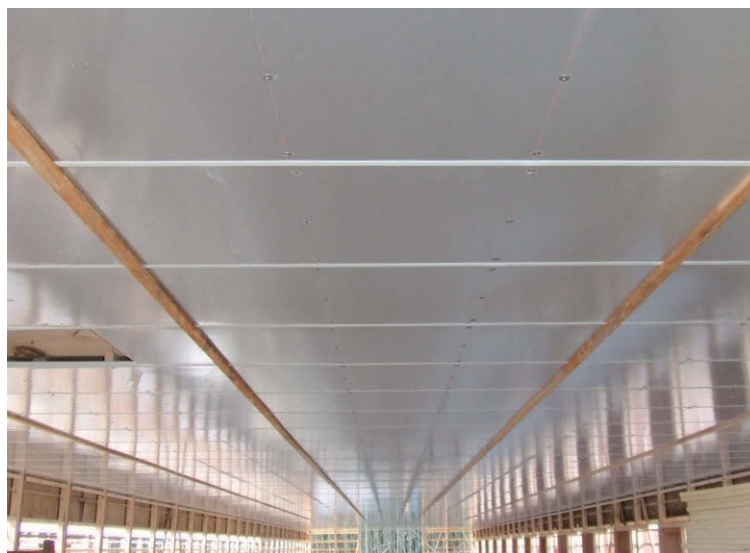
鶏舎天井施工例
